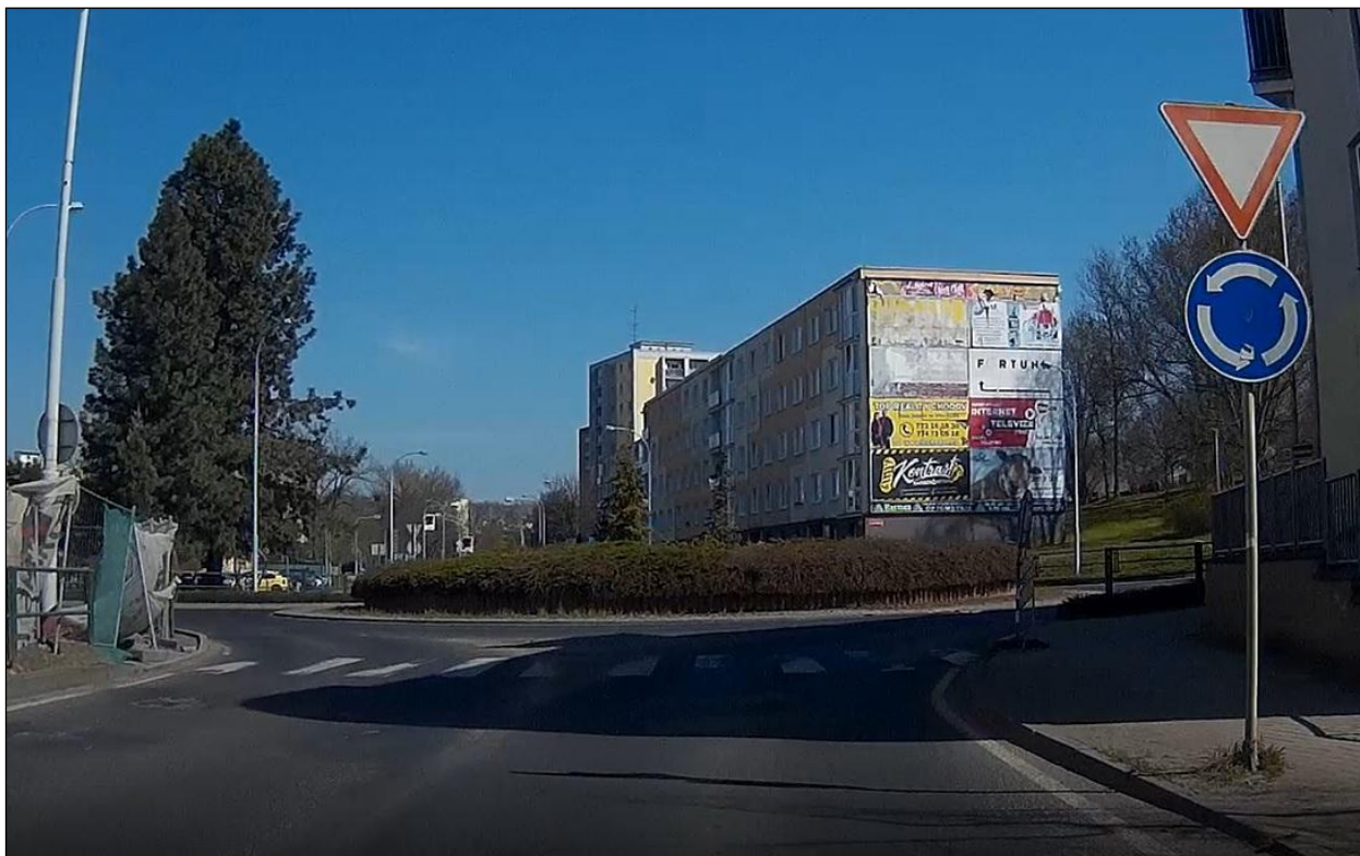
Obrázek 14: Lokalita 209-01 – Chodov – vjezd do okružní křižovatky ze silnice II/209 z jihu – nedostatečně označený a dlouhý přechod pro chodce, neviditelný okraj okružního pásu.
