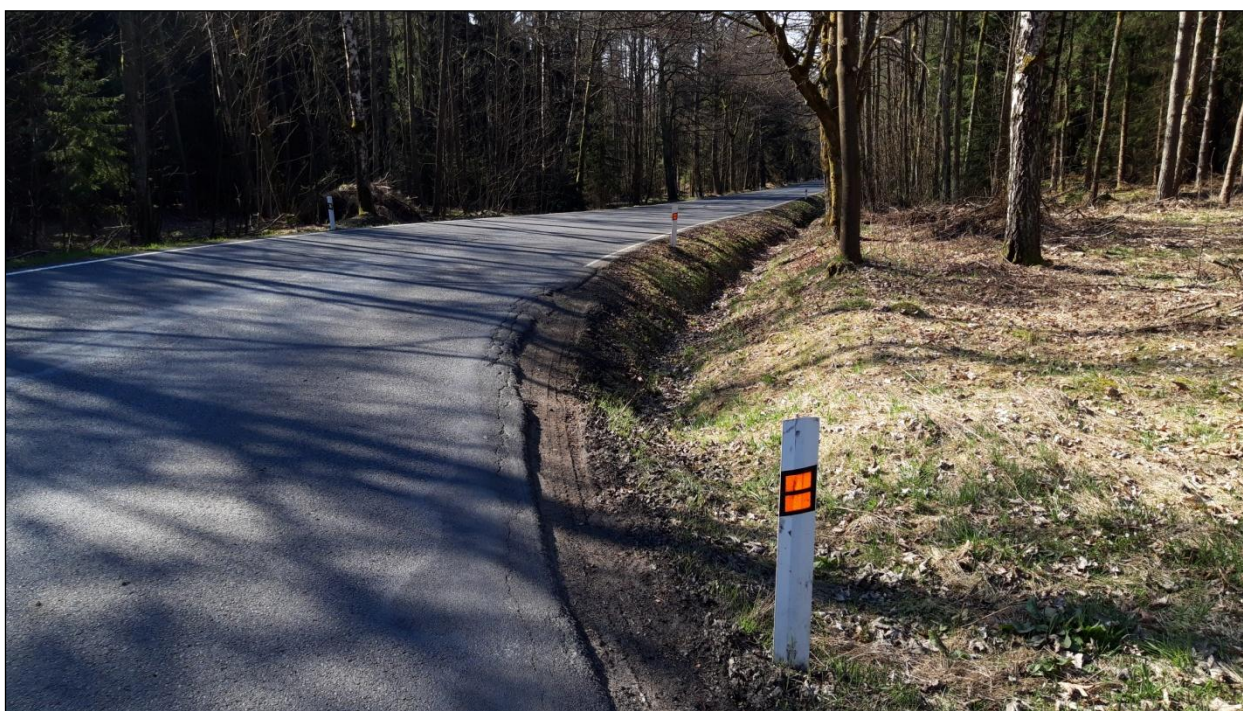
Obrázek 26: Lokalita 210-03 – Jindřichovice – stopy po najíždění velkých vozidel na krajnici
